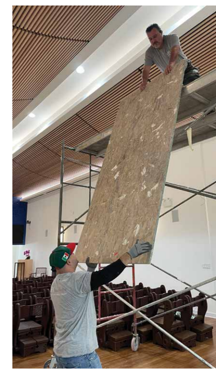
▶ 麥建民的施工團隊一直做到4月3日，趕在啟用前竣工。攝影 / 錢美臻
